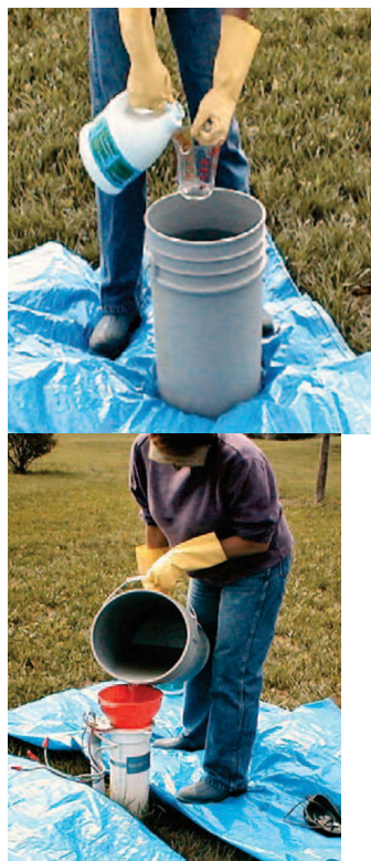
Figura 1. Determine la cantidad de blanqueador de cloro o hipoclorito de calcio necesario, mezcle y vierta la solución de cloro en el pozo. Fuente: Departamento de Minnesota de la Salud. www.health.state.mn.us/divs/eh/wells/waterquality/disinfection.pdf .
