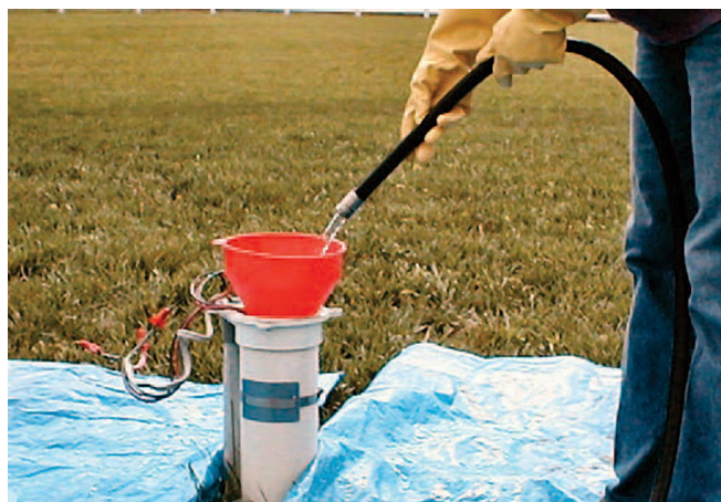
Figura 2. Haga circular el agua en el pozo y lave el interior de la carcasa. Fuente: Departamento de Minnesota de la Salud. www.health.state.mn.us/divs/eh/wells/waterquality/disinfection.pdf .
